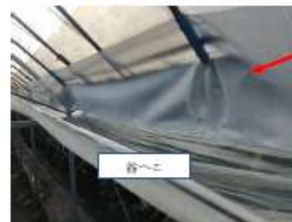
写真 2) DS 取付状況
